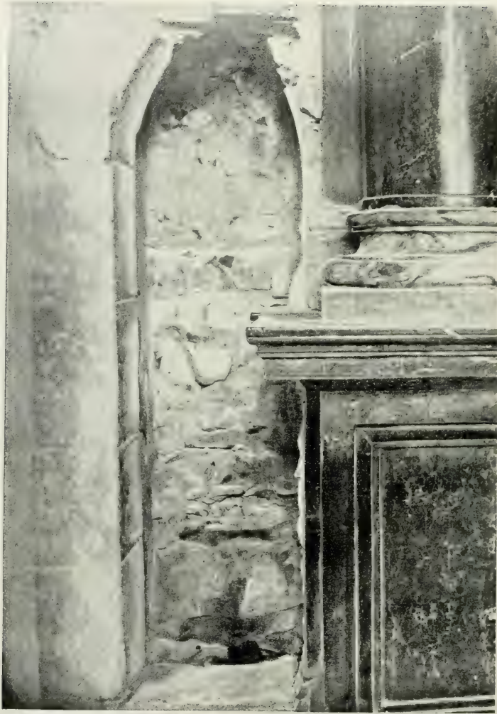
Fig. 33. Stary otwór obok portalu kaplicy Wazów.
